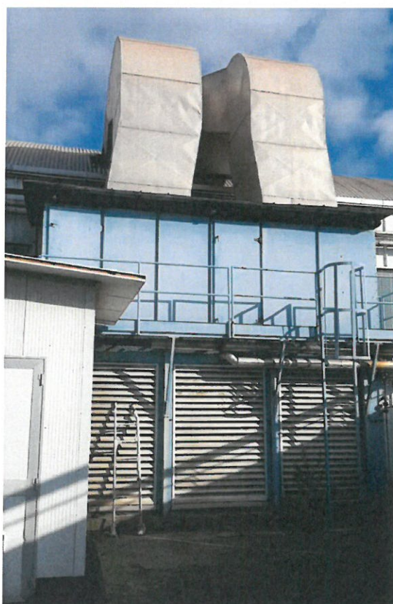
Foto 31 – Filtri cabina di verniciatura
