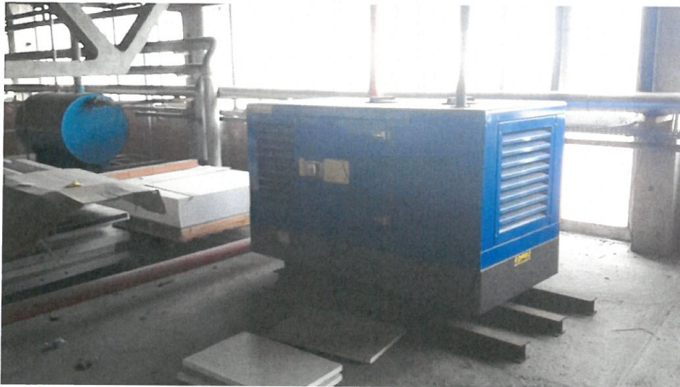
Foto 17 – Generatore di emergenza gruppo pompaggio pozzo
