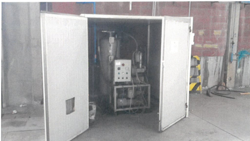
Foto 22 – Gruppo depressore in cabina insonorizzata
