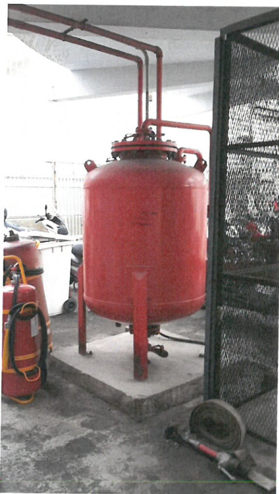
Foto 1 – Impianto Spegnimento a Schiuma Magazzini Chimici/Vernici
