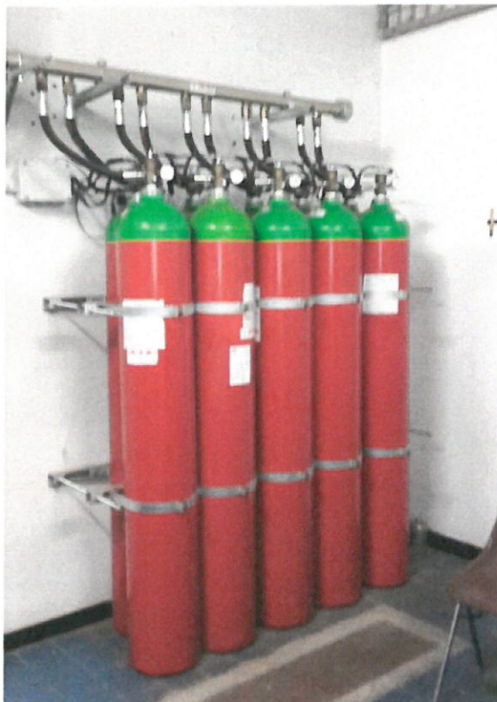
Foto 38 – Bombole impianto spegnimento automatico CED
